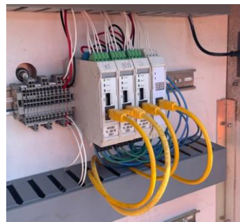
Bild 1: Ausrüstung vor Ort
